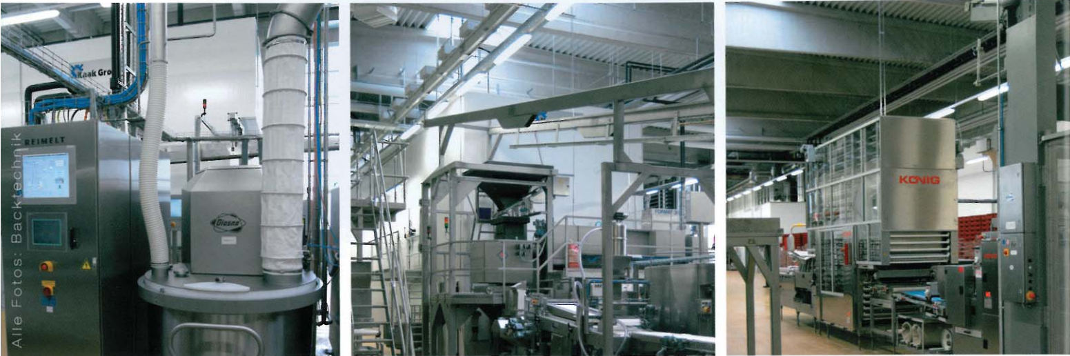
Links: Auch im Bereich Knettechnik ist die Produktion bestens ausgerüstet. Abhängig vom Teig sind Spiral- und Wendelkneter von Diosna installiert. Mitte: Brot- und Toastbrotanlage von Kaak. Rechts: Fast alle namhaften Hersteller lieferten Equipment nach Bergkirchen: Hier eine Brötchenanlage von König.
